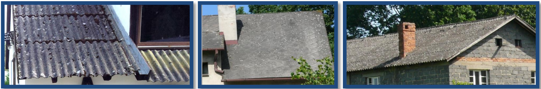
Najczęściej występujące wyroby zawierające azbest (plyta falista, płyta karo).
